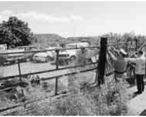
In alto il deposito abusivo di carcasse d'auto scoperto dalla Guardia di Finanza
