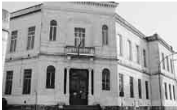
Il plesso Verga sarà realizzata, tra l'altro, la revisione del tetto di copertura e dei cornicioni
