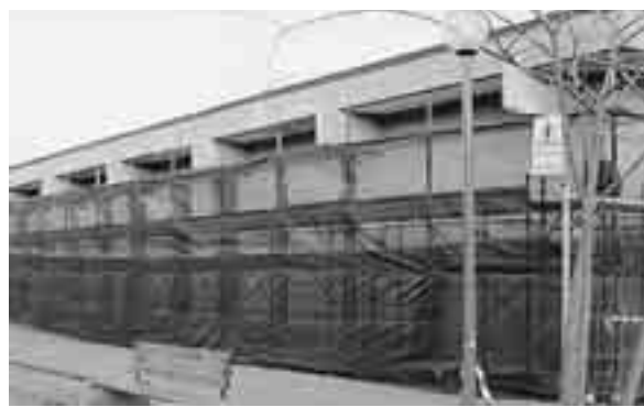
I lavori in corso all'ospedale di Giarre (Foto Di Guardo)
